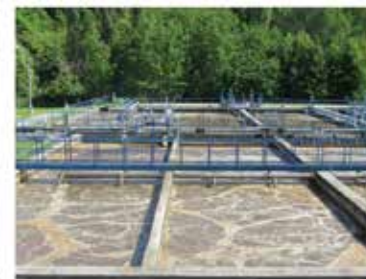
Obr. 7. Aktivační proces s jemnohříblinovou aerační
